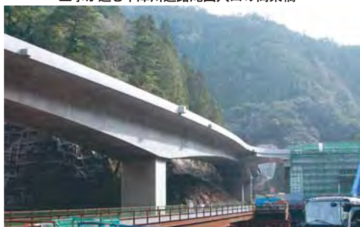
工事が進む十津川道路滝出入口の高架橋
